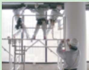
施工現場の写真を担当者が撮影
