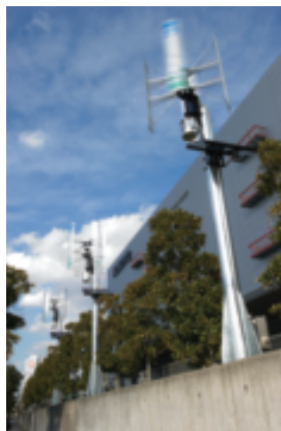
風力発電と太陽光発電を組み合わせたハイブリッド街灯。蓄電されたエネルギーは首都圏IDCでは夜間の看板照明(写真①)、近畿IDCでは通路、緑地帯の照明(写真②)、構内案内図の照明にそれぞれ利用されている。積算電力量表示パネル(写真③)。
