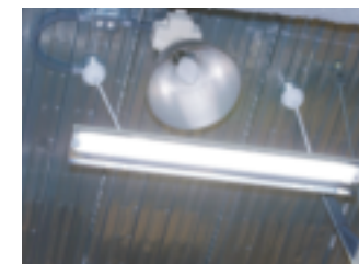
高反射板付き蛍光灯。ワット数はこれまでより低い明るさは従来以上。隣の丸い照明が従来の水銀灯。
