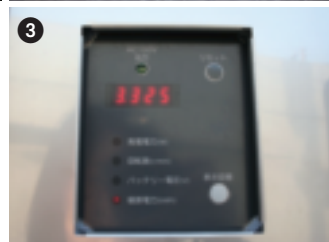
風力発電と太陽光発電を組み合わせたハイブリッド街灯。蓄電されたエネルギーは首都圏IDCでは夜間の看板照明(写真①)、近畿IDCでは通路、緑地帯の照明(写真②)、構内案内図の照明にそれぞれ利用されている。積算電力量表示パネル(写真③)。
