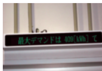
首都圏IDCお客様受付に設置されたエネルギー消費量計測結果の液晶表示板。
