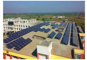
コクヨカムリン：パタルガンガ工場に設置されている太陽光パネル
