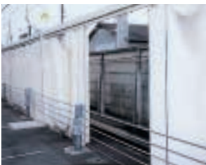
八尾配送センターに設置された防音シート
